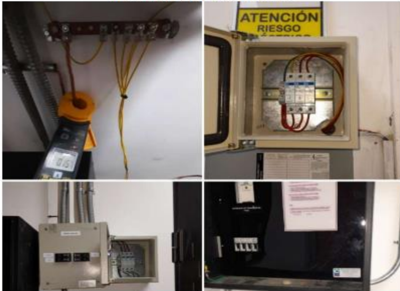
Instalación de puesta a tierra
