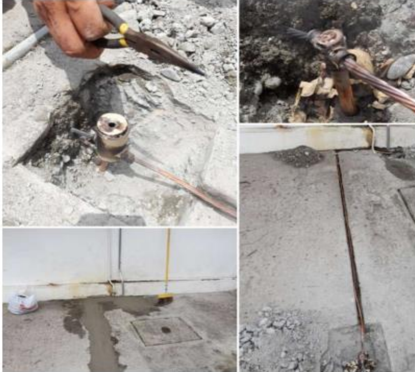
Instalación de puesta a tierra
