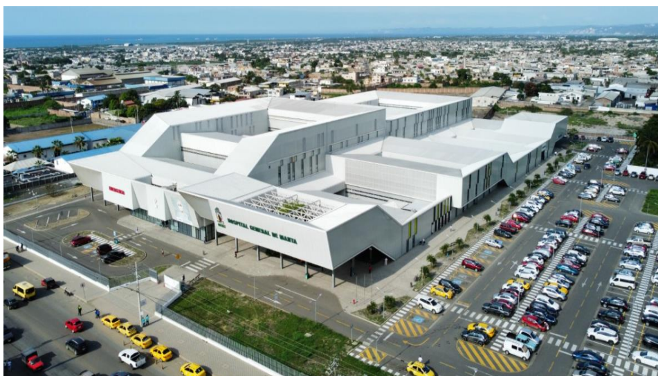
Imagen 1 - Vista aérea del Hospital General Manta
