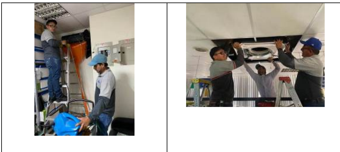
Imagen 4. Mantenimiento Aire Acondicionado de la Dirección Provincial.
