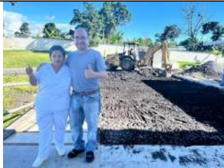
Plataforma parqueadero (antes)
