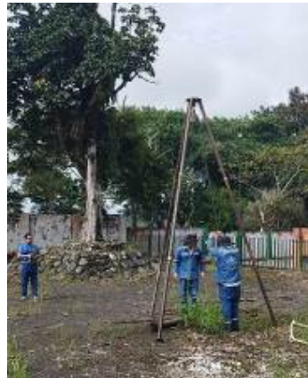
Imagen 3. Estudio de suelos previo a la construcción de la bodega para la Dirección Provincial.
