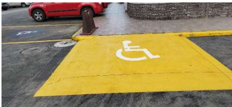
Fotografía 17. Accesos y baterías sanitarias para personas con discapacidad.
