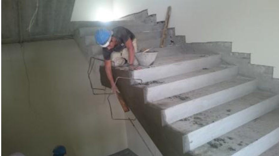
Fotografía: Personal trabajando en la Unidad Médica en el enlucido de gradas
