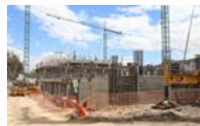
Hospital del IESS Quito Sur
